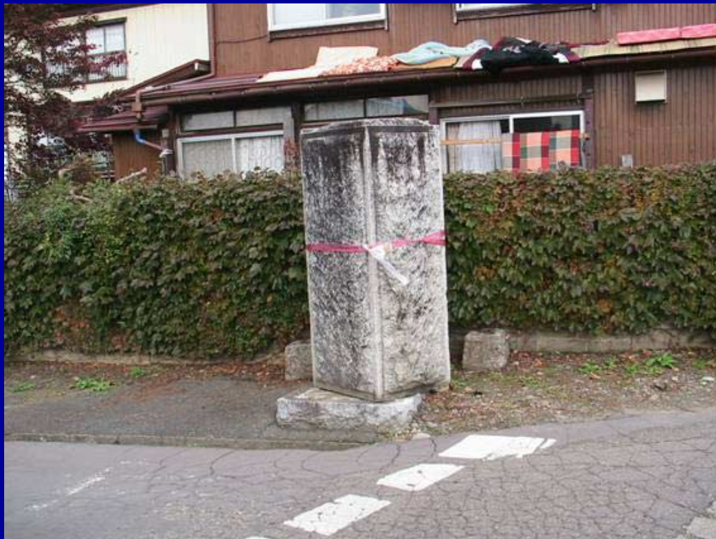
新潟県十日町市立南中学校の門柱
